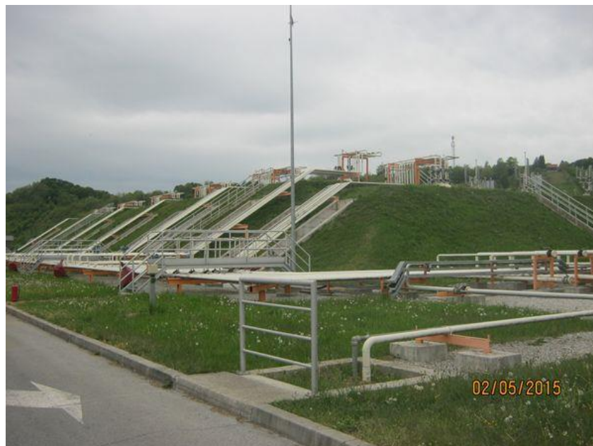
Slika 5. Spremnici terminala (drugi pogled)
