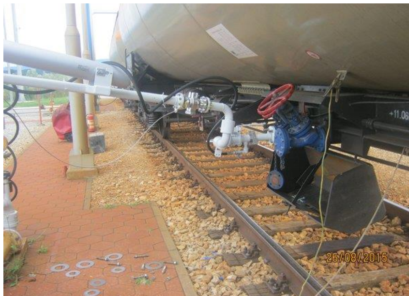
Slika 33. Spojena istakačka ruka na vagon cisternu
