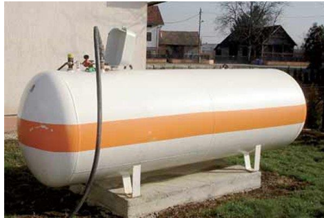
Slika 1. Stabilni plinski spremnik
