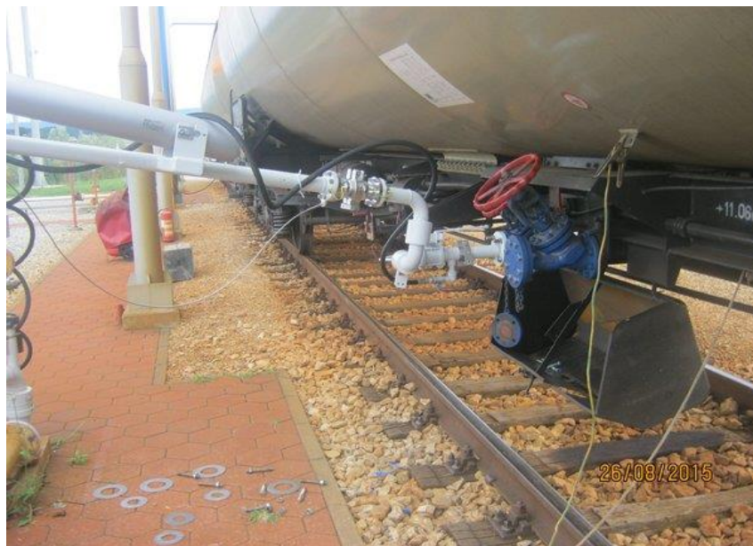
Slika 33. Spojena istakačka ruka na vagon cisternu
