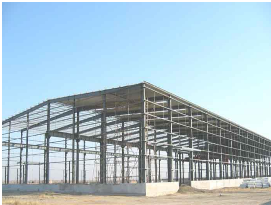
Slika 1 - Primjer čelične rešetkaste konstrukcije [8]
