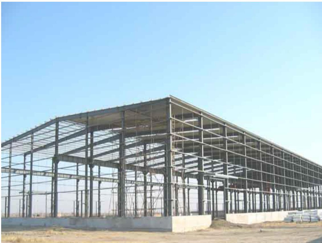
Slika 1 - Primjer čelične rešetkaste konstrukcije [8]
