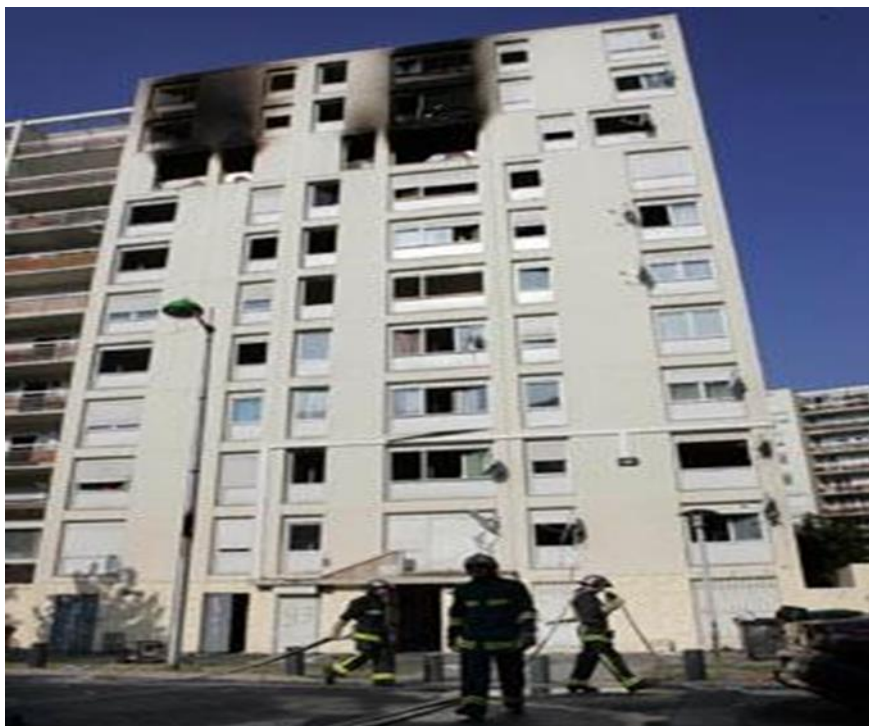
Slika 1. Posljedica požara na višem objektu
