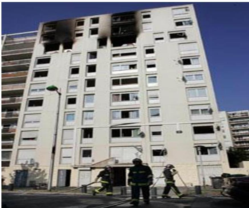
Na slici 1 se mogu vidjeti posljedice požara koji je nastupio na gornjem dijelu stambene zgrade. Plamen se široj vertikalno prema gore i uništio vanjsko pročelje zgrade i zahvatio katove iznad.
