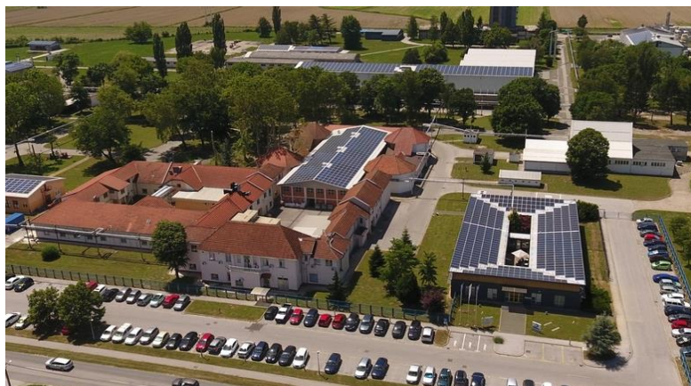
Slika 14. Solarna elektrana Genera [19]
