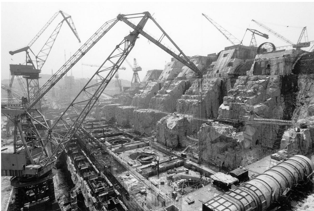
Slika 24. Hidroelektrana Tri Klanca tijekom izgradnje [44]
