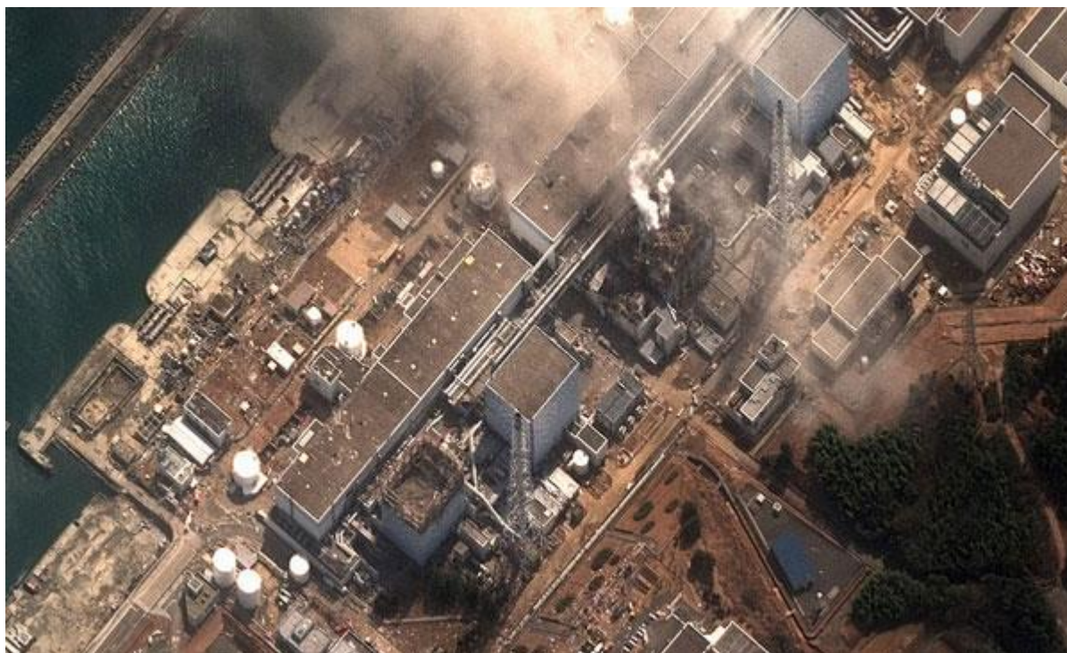
Slika 20. Oštećenje kompleksa nuklearne elektrane Fukushima Daiichi [38]
