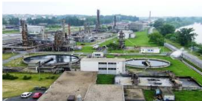
Slika 7. Centralni uređaj za obradu otpadnih voda OV-4 [11]
