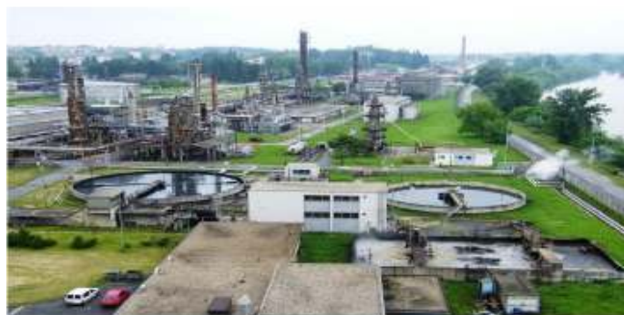
Slika 7. Centralni uređaj za obradu otpadnih voda OV-4 [11]
