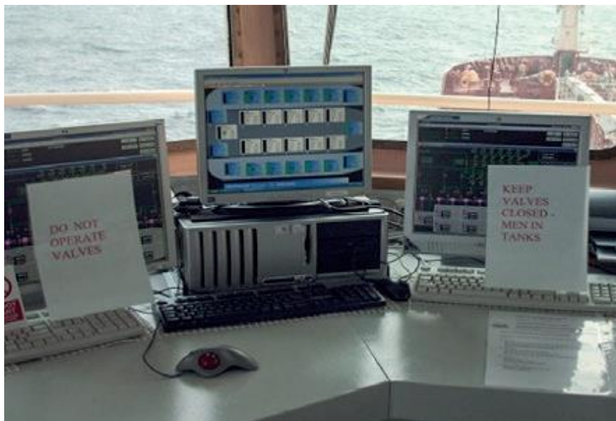
Slika 4. Znak upozorenja prikazan na upravljačkoj stanici
