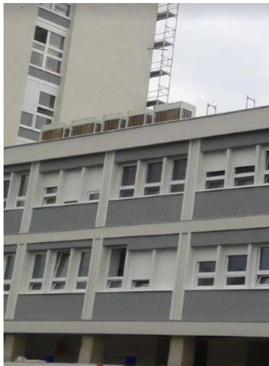
Slika 13. Primjer ugrađene PVC stolarije na OB Karlovac
