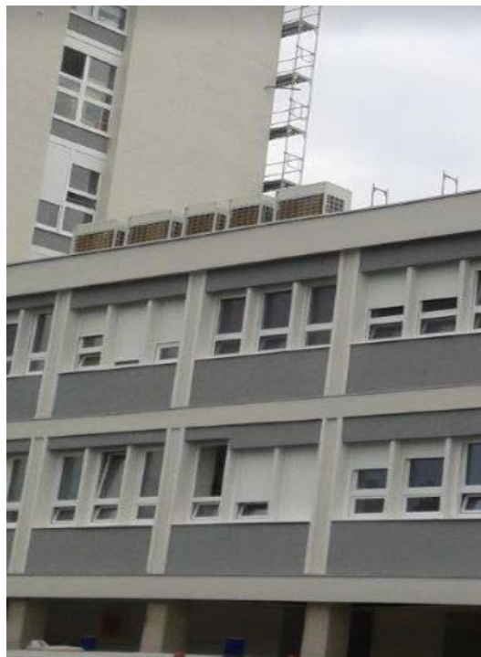
Slika 13. Primjer ugrađene PVC stolarije na OB Karlovac
