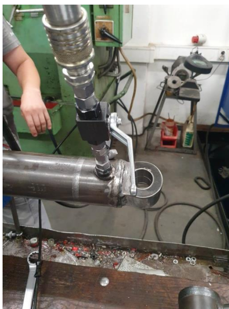
Slika 92. Zatvoren ventil priključnice (1).
