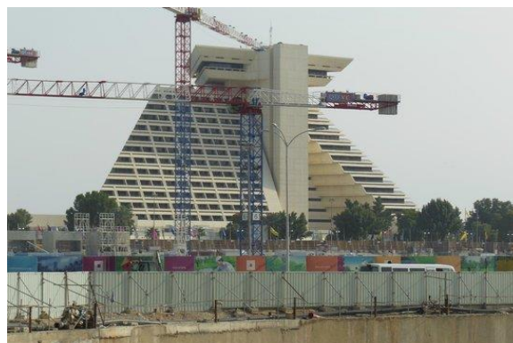
Slika 4. Gradnja Sheraton Doha Hotela
