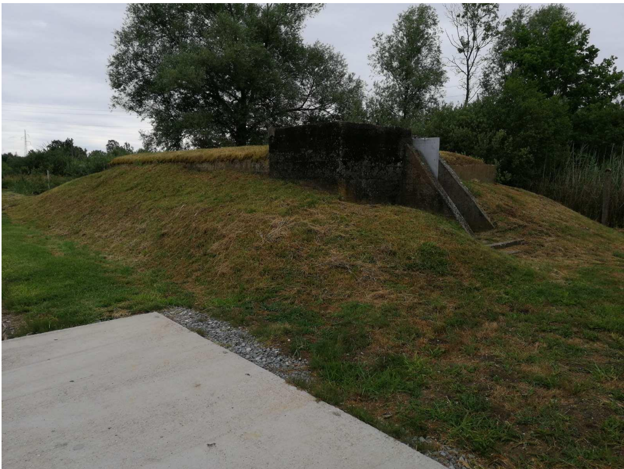
Slika 15. Ukopani spremnik vode [19]
