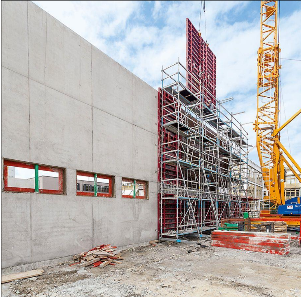
Slika 31. Primjena skela i oplata pri izgradnji konstrukcije
