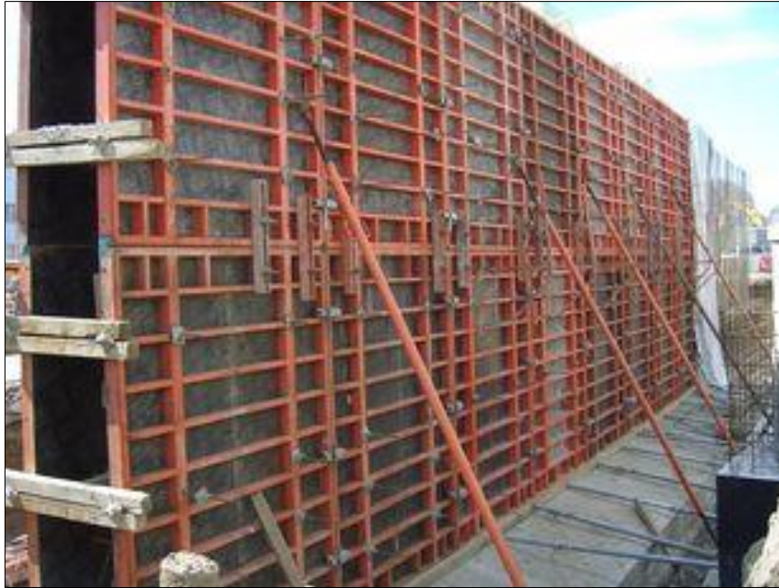
Slika 4. Velikoplošna oplata za vertikalne konstrukcije
