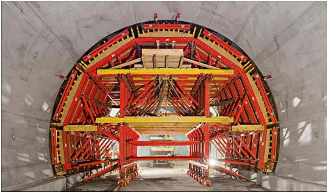
Slika 7. Tunelska oplata
