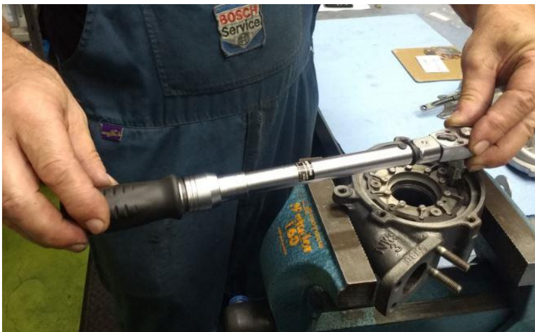
Slika 61 Pritezanje vijaka varijabilne geometrije moment ključem [17]
