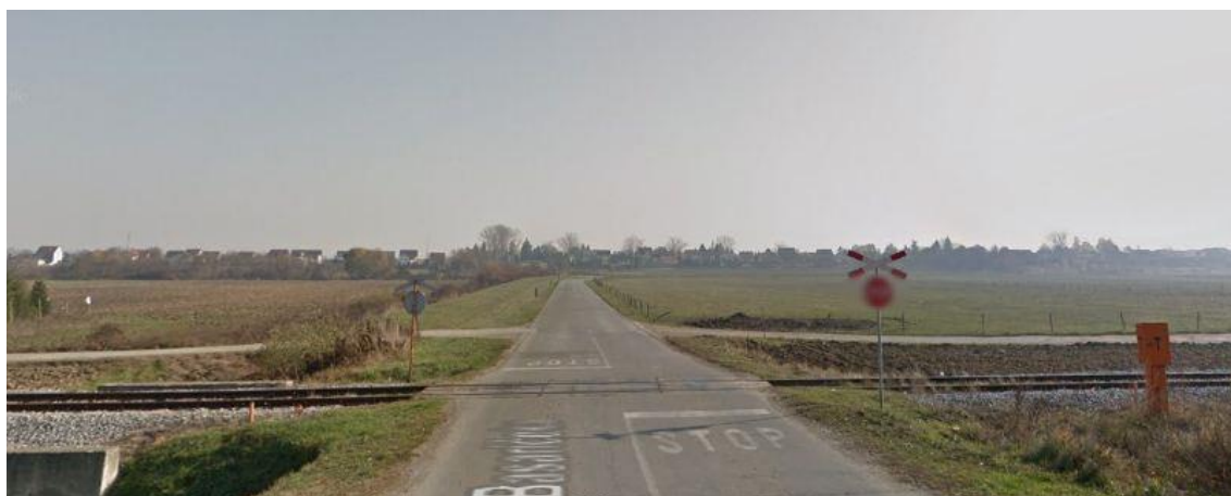
Slika 7. Predodžba pasivno osiguranog željezičko-cestovnog prijelaza [3]
