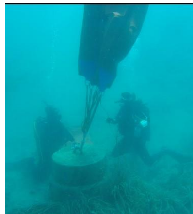
Sl. 35. Postavljanje i napuhavanje padobrana [3]
