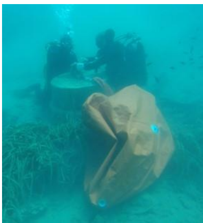
Sl. 35. Postavljanje i napuhavanje padobrana [3]
