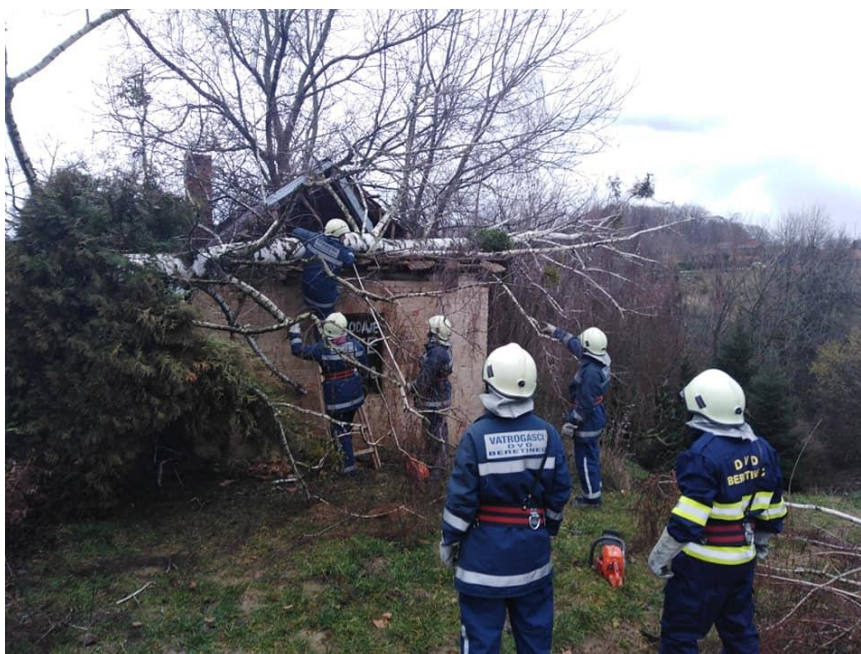
Sl.19. Uklanjanje srušenog stabla s objekta [8]
