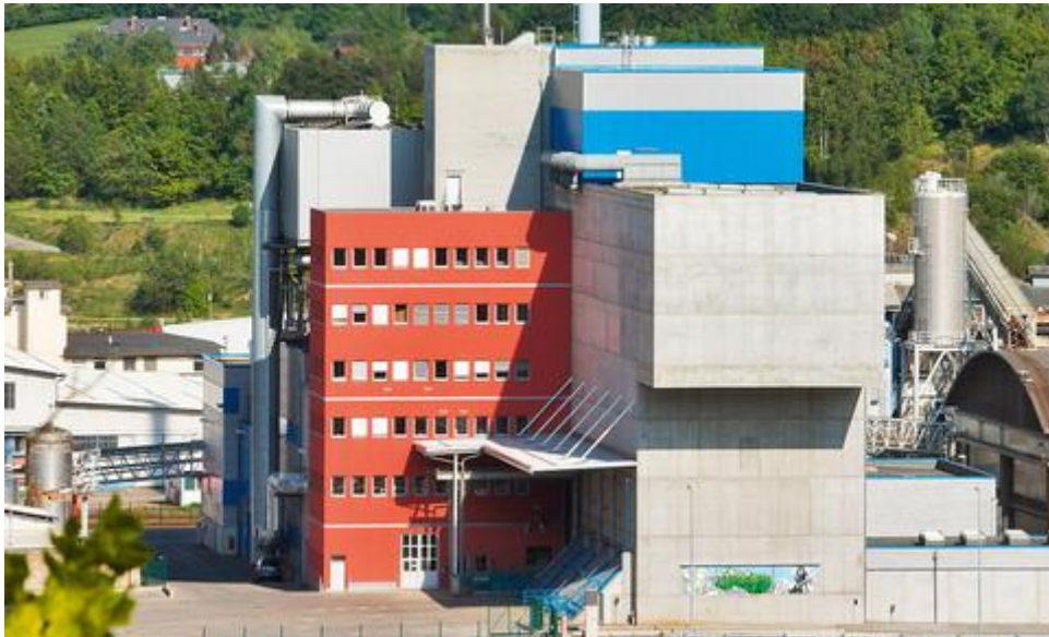
Sl. 3. Postrojenje za termičku obradu otpada [12]
