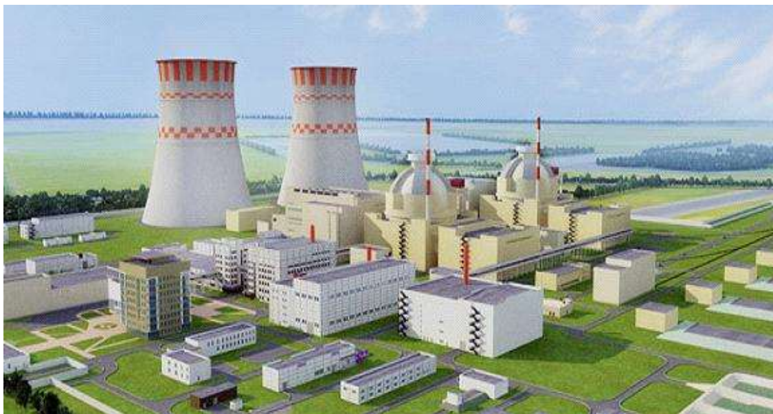
Slika 1. Budući izgled nuklearne centrale Rooppur [1]
