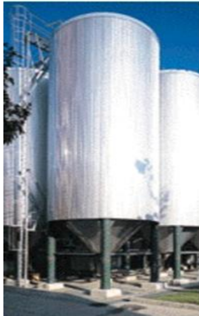
Slika 3. Cilindrično-konusni fermentori (CKF)
