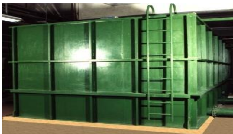
Sl. 12. Preljevni akumulacijski spremnik [16]
