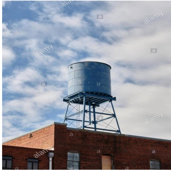
Sl. 11. Visinski spremnik vode [17]
