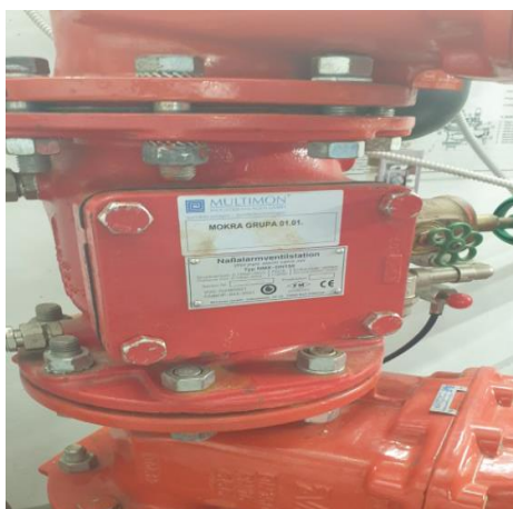
Sl. 16. Sprinkler ventil mokri [10]
