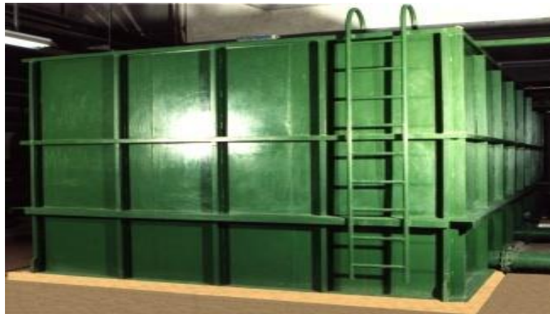
Sl. 12. Preljevni akumulacijski spremnik [16]
