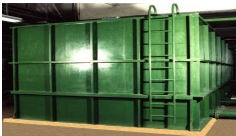
Sl. 12. Preljevni akumulacijski spremnik [16]
