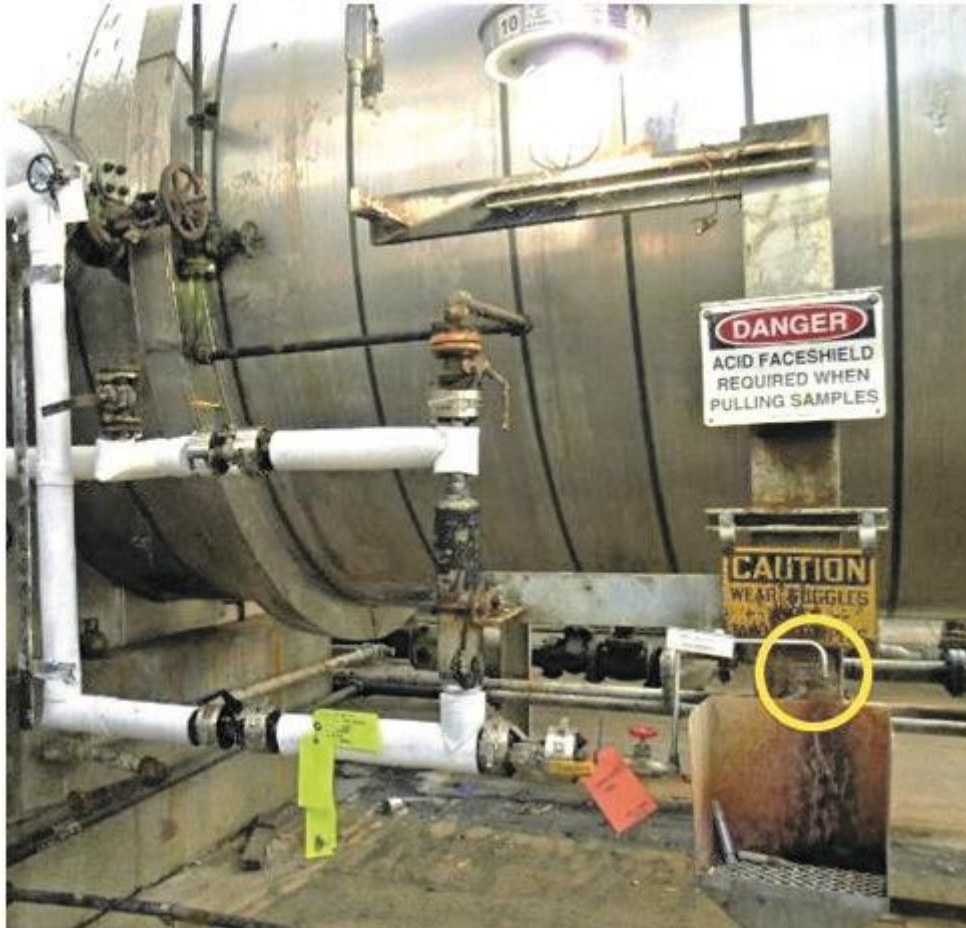
Slika 11: Fotografija uzorka sumporne kiseline u rafineriji tvrtke Y. Fotografija prikazuje tipičnu stanicu za uzorkovanje sumporne kiseline u rafineriji. Žuti krug identificira mjesto na kojem operater dobiva uzorak kiseline. [Proces safety culture case study Martinez, California, No. 2014-02-I-CA]
