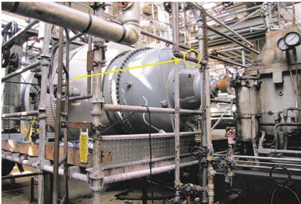
Slika 14: Fotografija lokacije incidenta 10. ožujka 2014. godine. Kao što je prikazano na slici 12, na toj su privremenoj platformi skele bila dva radnika i rezali su cijev (žuti krug) prijenosnom tračnom pilu. [Proces safety culture case study Martinez, California, No. 2014-02-I-CA]
