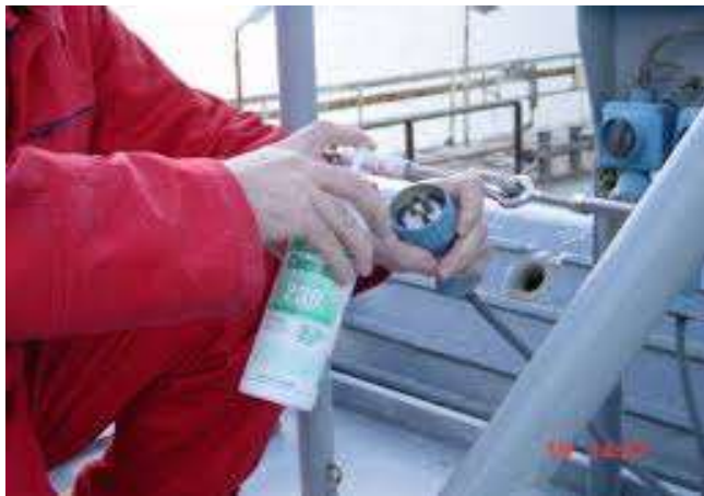
Slika 16. Primjena inhibitora za zaštitu elektronske komponente (Juraga i sur., 2006.)
