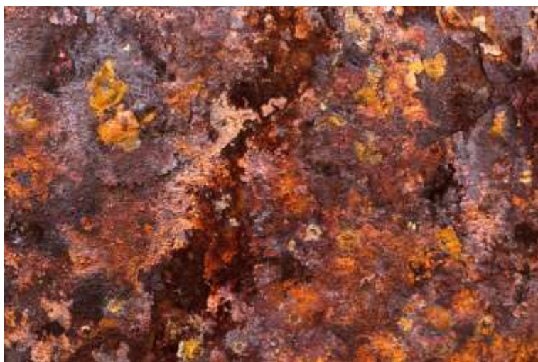
Slika 4. Korozija čelika (Anonymus, 2017.)
