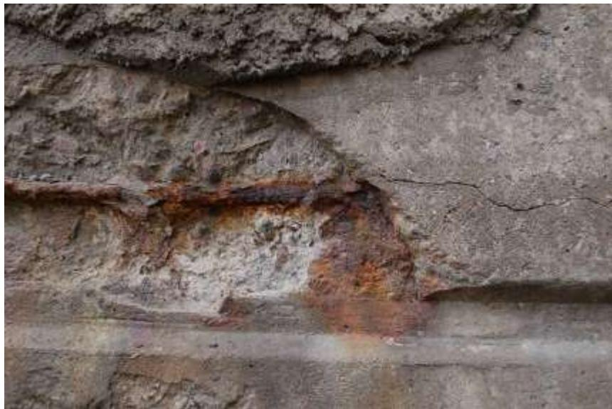
**Slika 5.** Korozija armature u betonu (De Carufel, 2018.)
