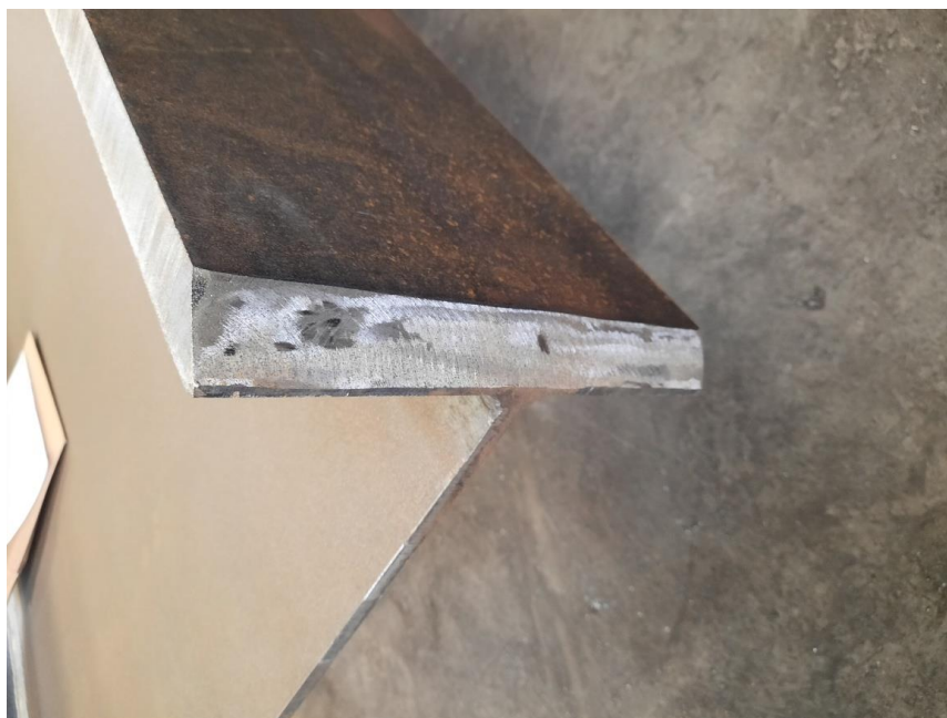
Slika 58. Skošnje na I profilu – pogled 2
