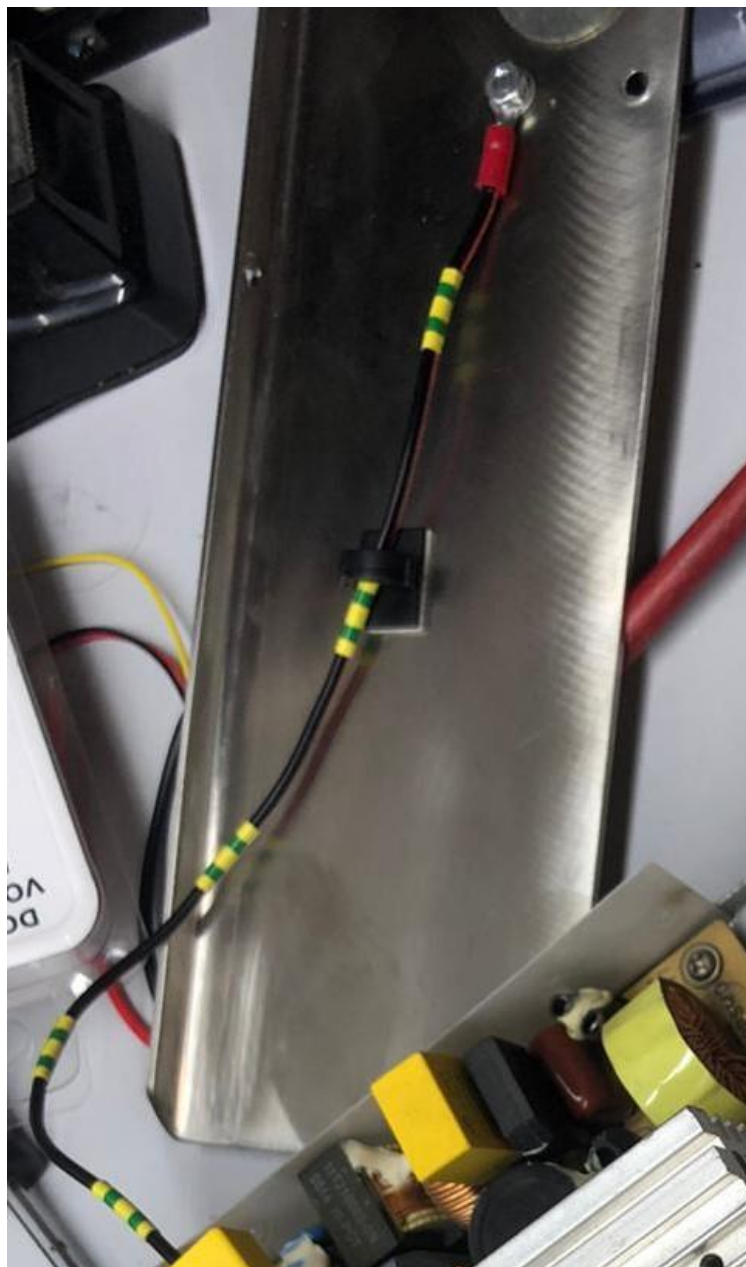
Slika 28. Provedba uzemljenja kućišta
