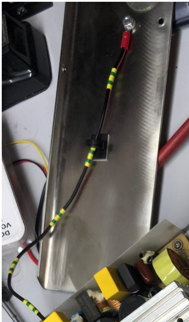
Slika 28. Provedba uzemljenja kućišta
