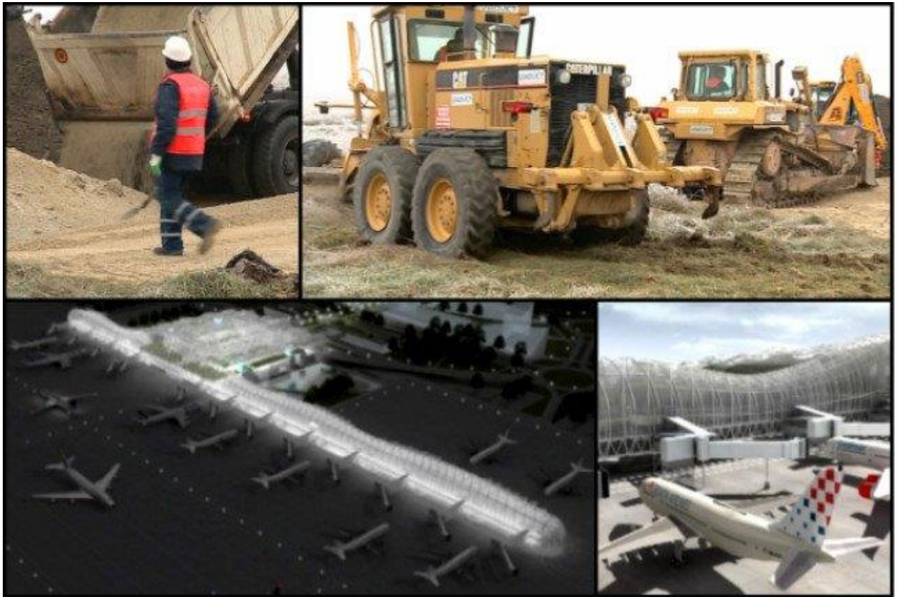
Slika 10. Izgradnja zračne luke Zagreb
