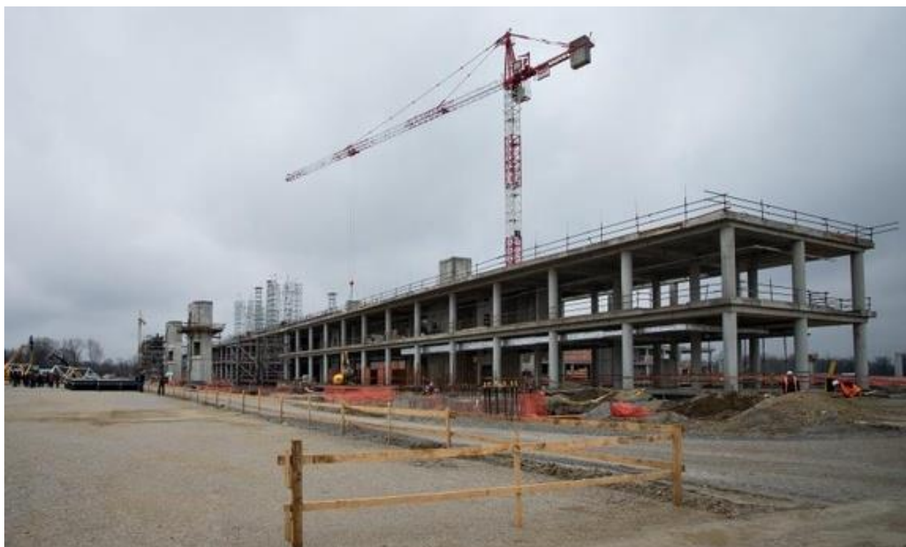
Slika 3. Izgradnja terminala zračna luka Zagreb
