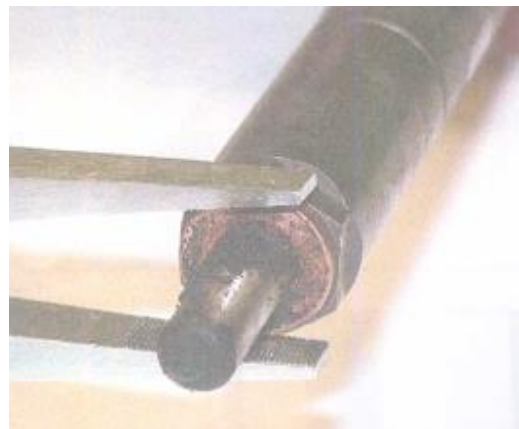
Slika 21 Demontaža bakrene podloške
