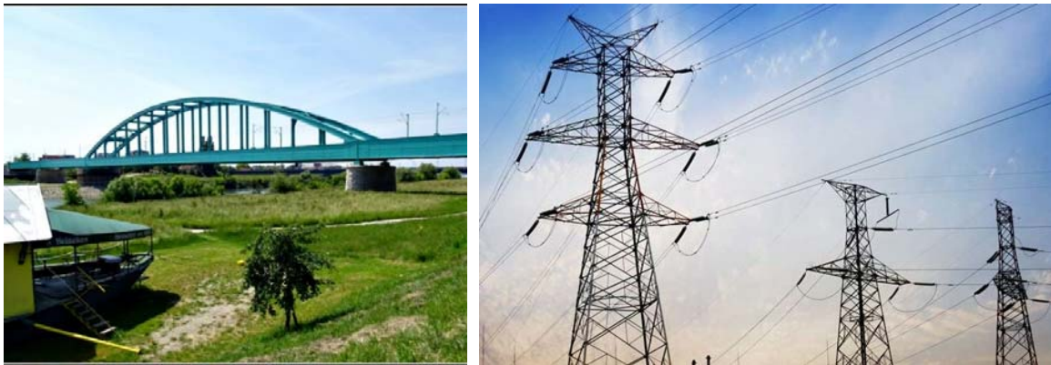
Slika 13. Rešetkaste konstrukcije; primjer Željezničkog mosta na rijeci Savi u Zagrebu, te dalekovoda u Varaždinu [21]
