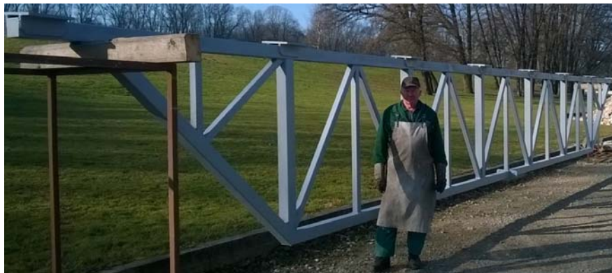
Slika 10. Rešetkasti nosač krovne konstrukcije kinodvorane, 28.01.2016, Donja Stubica
