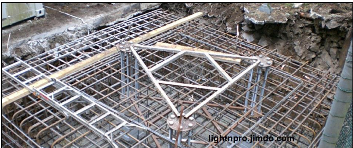
Slika 12. Predodžba A uzemljivači [22]
