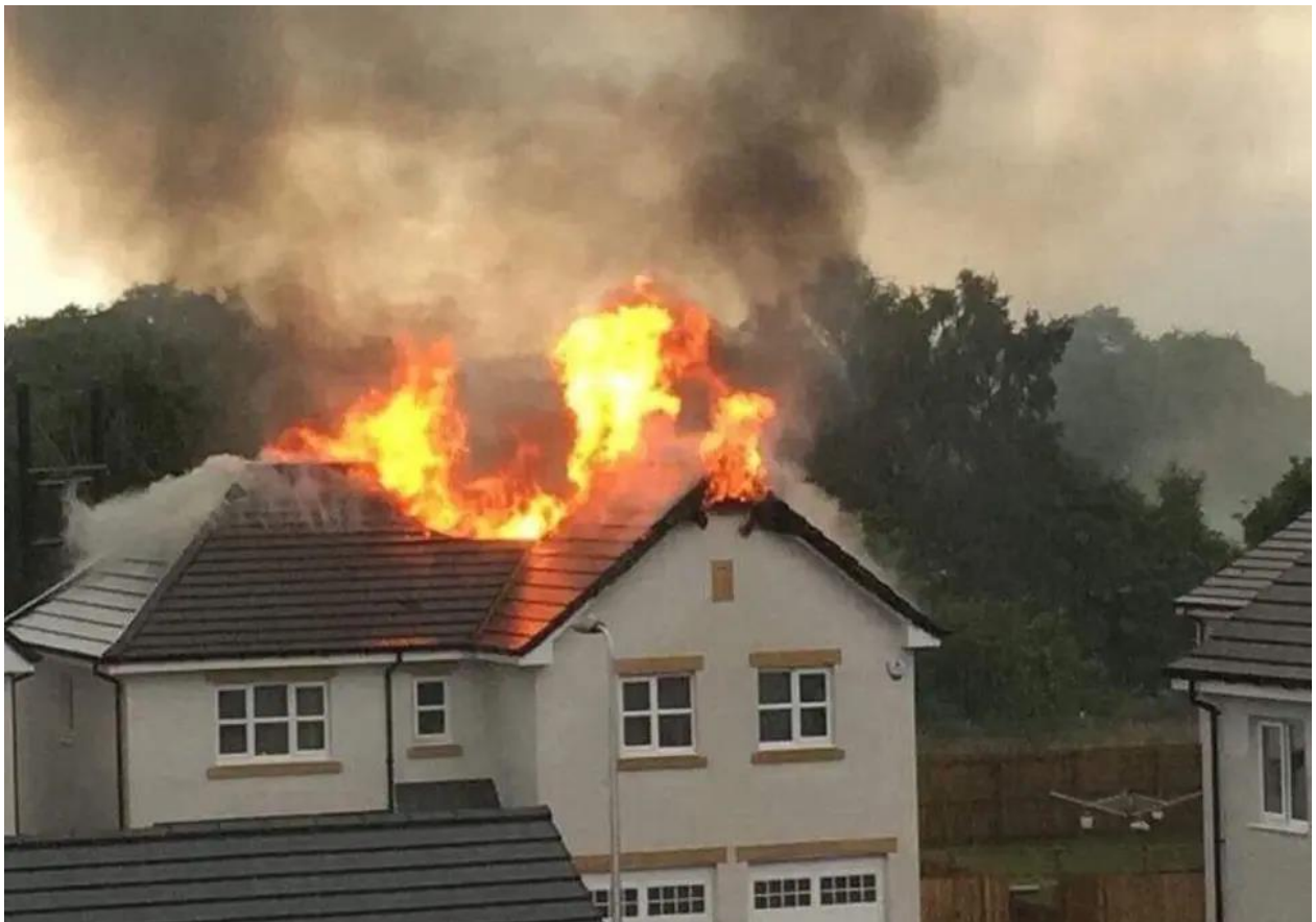
Slika 7. Predodžba požar uslijed udara munje [19]
