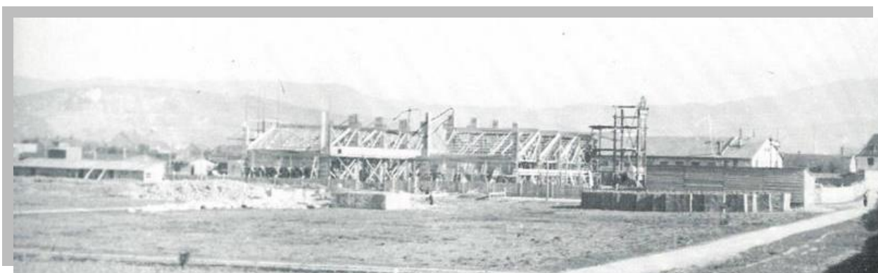
Slika 2. Gradnja tvornice Rade Končar
