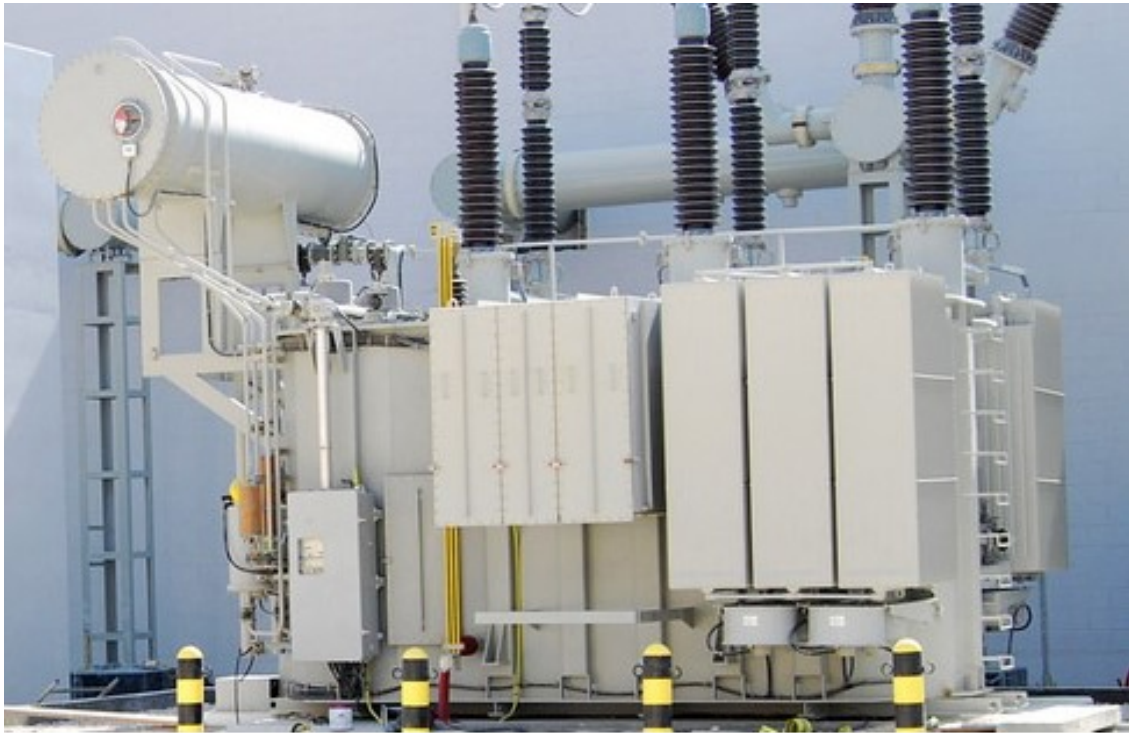
Slika 4. Energetski transformator [11]
