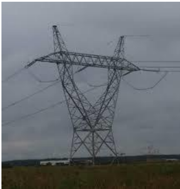
Slika.2.2. Jednostruko čelično-rešetkasti stup " Y-stup"
