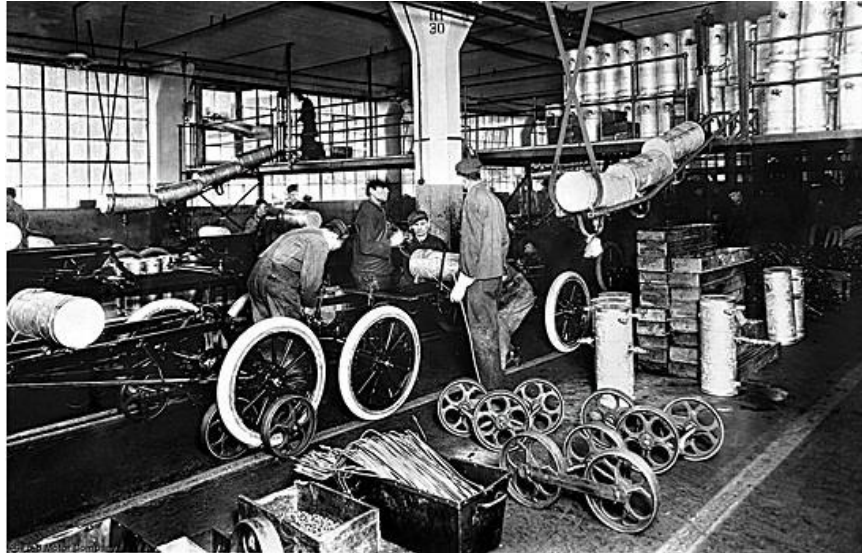
Sl. 6. „Montažna traka“, tvornica Ford Motor Company, 1913.
