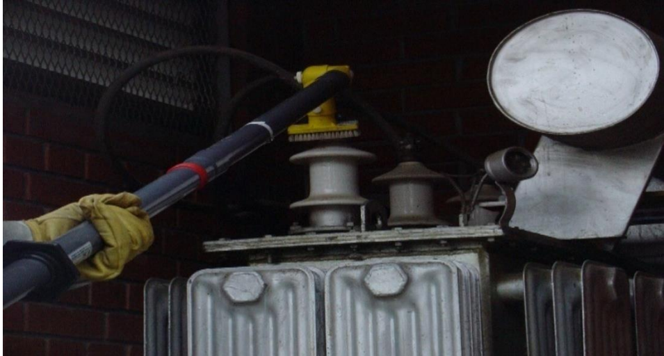
Slika 5. Čišćenje dijelova na transformatoru sa zaobljenom četkom
