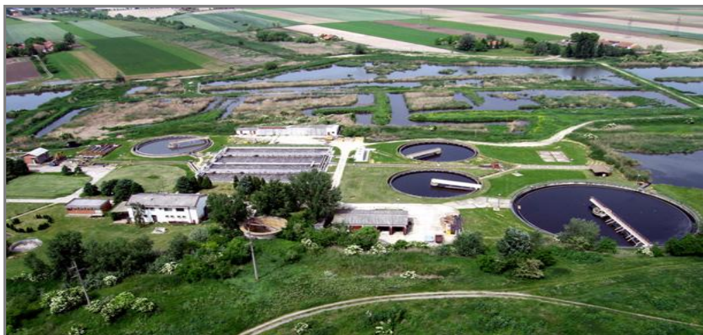
Slika 5. Pročišćivači otpadnih voda
