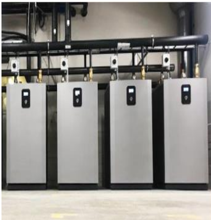
Slika 6.23. Dizalica topline Thermia MEGA XL [16]
