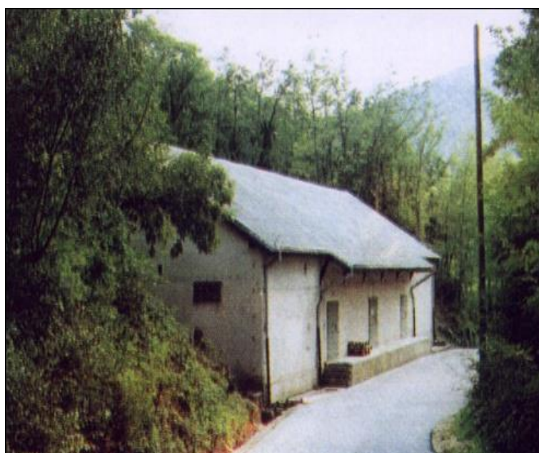
Slika 6. Nadzemni skladišni objekt za smještaj i čuvanje eksplozivnih sredstava vrste M [1]
