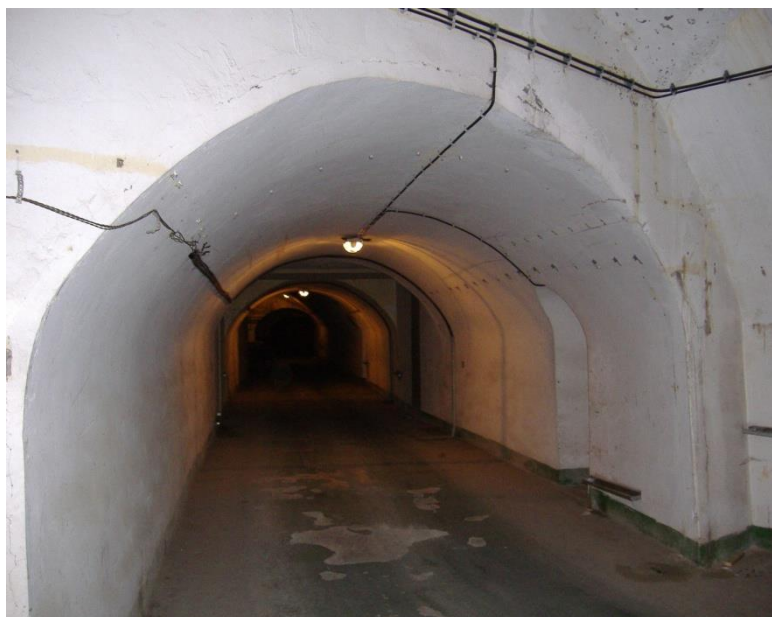
Slika 8. Podzemno skladište eksplozivnih sredstava tunelskog tipa s više komora [3]
