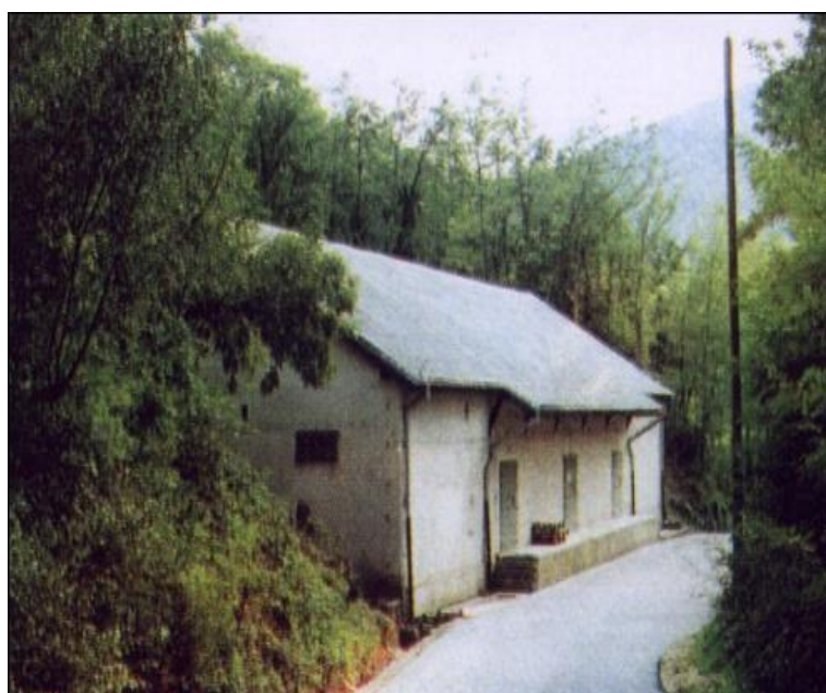
Slika 6. Nadzemni skladišni objekt za smještaj i čuvanje eksplozivnih sredstava vrste M [1]
