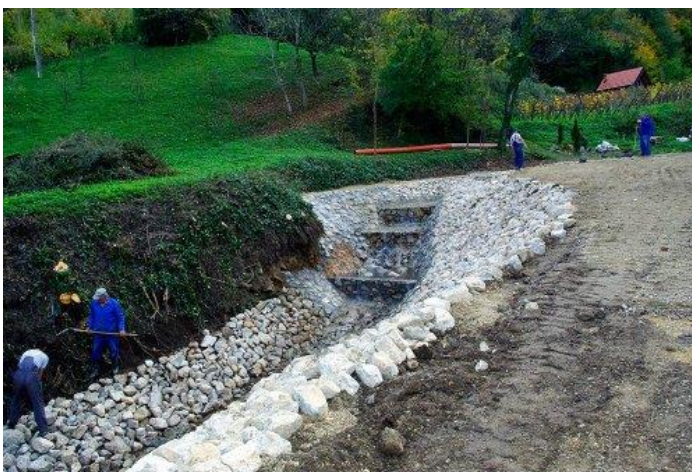
Slika 17) Izgradnja korita vodotoka
