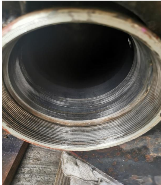
Slika 41. Oštećenja riseva po cijevi cilindra
