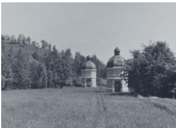
Slika 2. zdenici I i II na Vodocrpilištu Borlin nakon izgradnje 1914.
